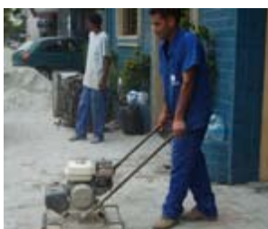
Compactação inicial, revisão, ajustes, espalhamento de areia, rejuntamento e compactação final
