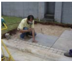
Execução de corte, ajustes e alinhamento
