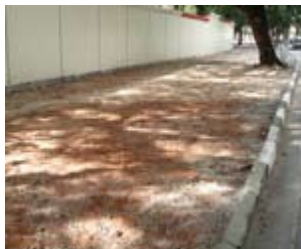
Nivelamento e compactação do subleito (terreno)
