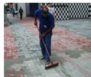
Limpeza e liberação ao tráfego
