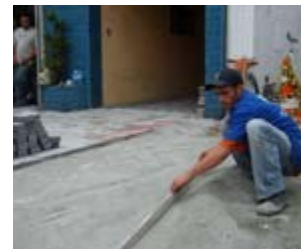
Espalhamento e nivelamento (sarrafeamento) da areia de assentamento
