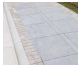
Limpeza e liberação ao tráfego
