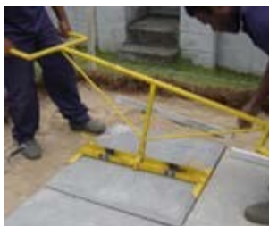
Colocação das peças de concreto com saca-placas
