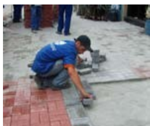
Colocação das peças de concreto, alinhamento, cortes e ajustes
