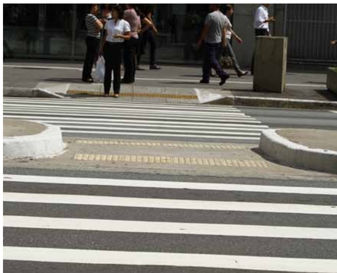
Figura 6: Rebaixamento de canteiro central Fonte: Programa Passeio Livre, Prefeitura de São Paulo
